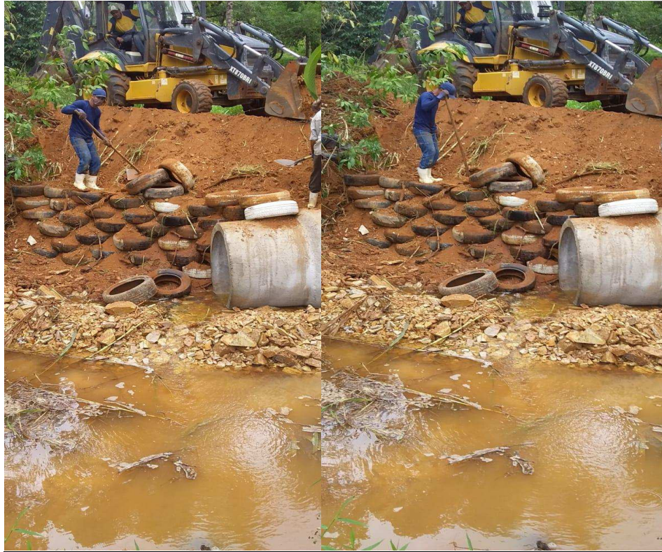
Estrada Ferreirão, reaproveitamento de pneus, encabeçando tubulões.
